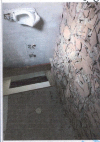
F7: Substitución de Lometa fracturada del lobby
