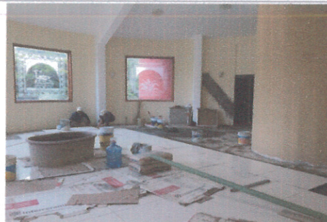
F7: Sustitución de Loseta fracturada del lobby
