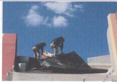
F3: Retiro de impermeabilizante deteriorado
