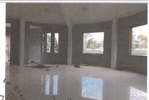
F10: aplanado fino de muros agrietados
