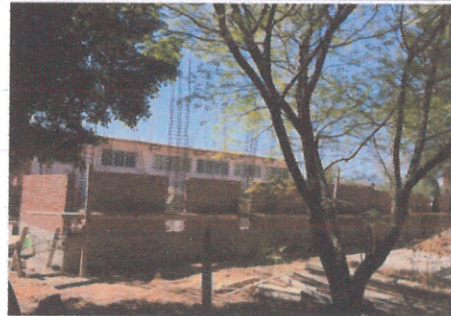
F4: muros de ladrillo, castillos y cadenas
