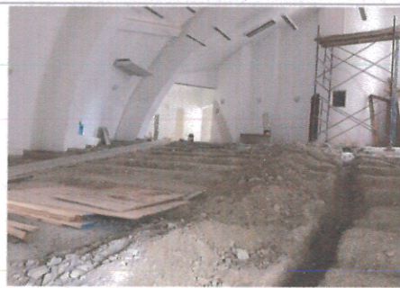
F4: Excavación para ductería eléctrica del Paraninfo
