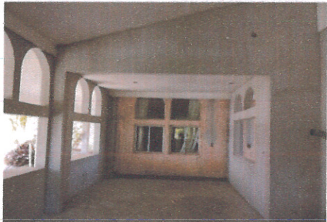
F3: Interior Edificio de servicios escolares, aplanados, preparación para pisos
