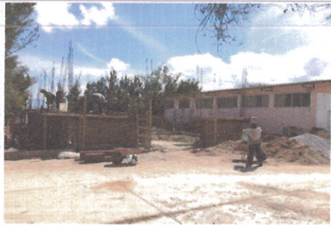
F1: Vista frontal del almacén de servicios generales
