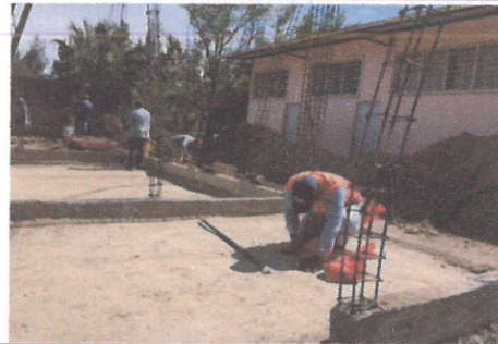
F2: Extracción de calas para pruebas de laboratorio
