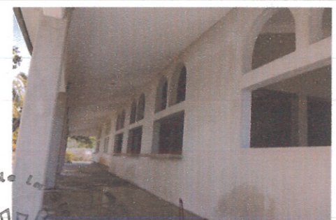
F5: Edificio de servicios escolares, área de atención a alumnos, aplanados
