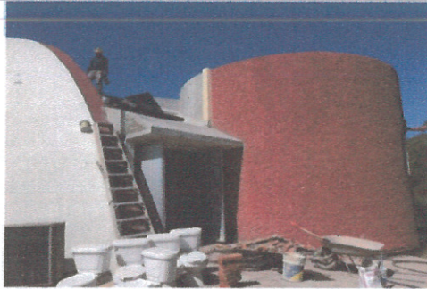
F6: Retiro de muebles sanitarios deteriorados
