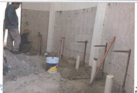
F9: Instalacion hidraulica y sanitaria nueva
