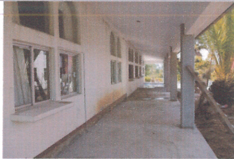
F1: Edificio de servicios escolares, aplanados
