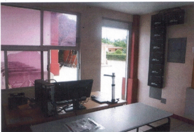
Instalacion de paneles de control
