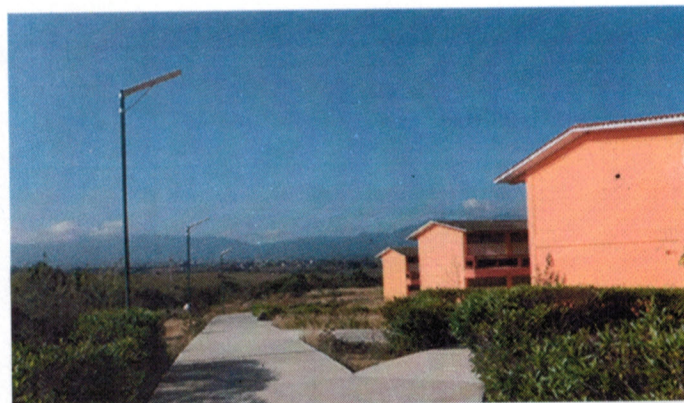
Luminarias hacia los modulos de aulas
