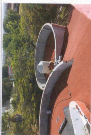
F3: Colocación de impermeabilizante nuevo
