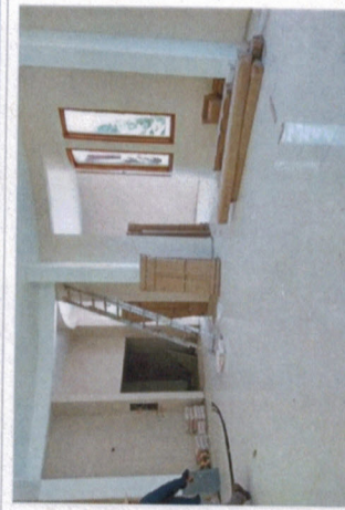
F7: Pintura vinilica en muros reparados
