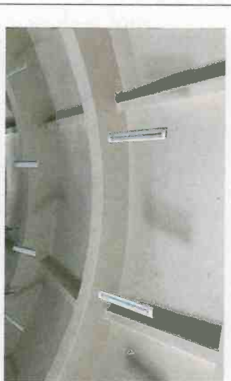
F2: Acabado fijo, pintura y luminarias - area de espejadores
