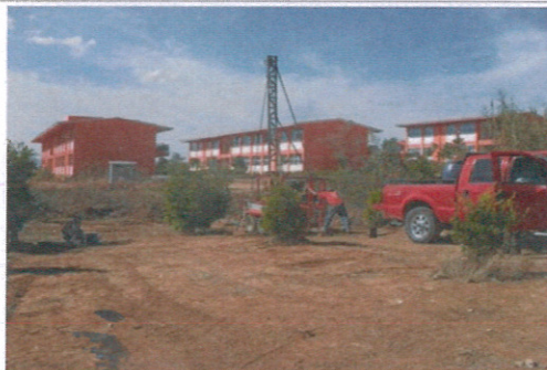
F4- Area para desplantar el edificio
