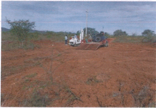
F1- Área para desplantar el edificio.
