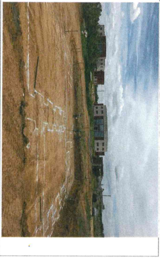
F1- Trazo y nivelación de ceras CEDGE
