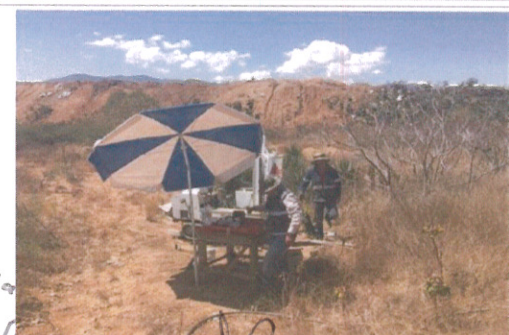
F5- Mecanica de Suelos para el edificio de CEDGE
