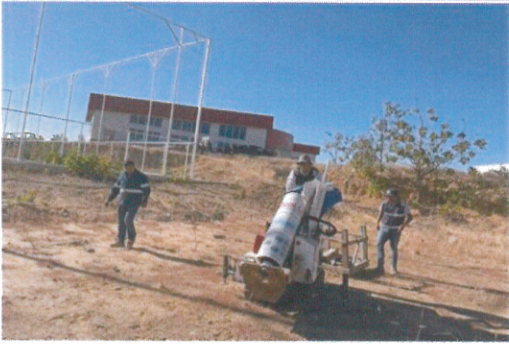
F1- Area para el edificio de Cancha
