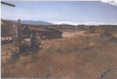
F3- Mecanica de Suelos para el edificio de CEDGE
