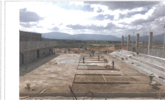
F5- Colado de pisos - Cancha
