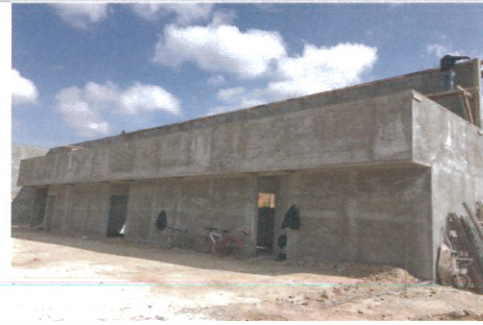
F2- Aplanado en Muros - Cancha
