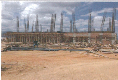
F2- Acero en Columnas - Cafetería
