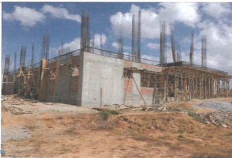
F4- Acero en trabes - Cafetería
