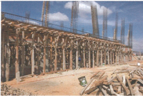
F3- Cimbra en nervaduras - Cafetería
