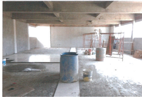
F2- Acabado fino en muros y columnas CEDGE
