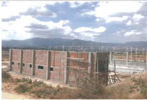
F1- Aplanado en Muros - Cancha
