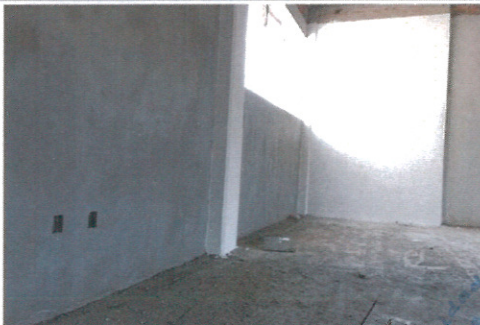
F3- Aplanado fino en Muros CEDGE
