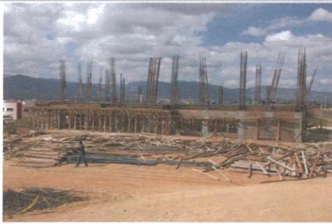
F1- Cimbrado de Trabes - Cafetería
