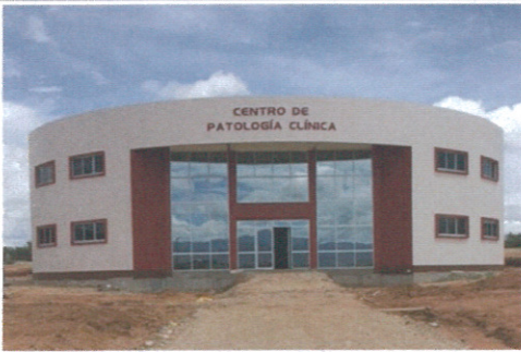
F1- Fachada principal
