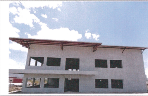
F4- Cubierta de Estructura metalica - Cafetería
