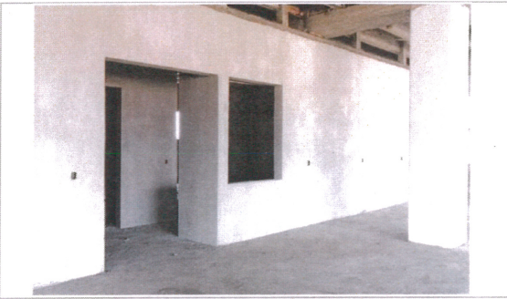
F3- Aplanado fino en interior - Cafetería
