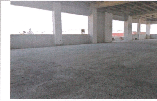
F2- Fiermes de concreto - Cafetería
