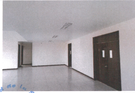
F4- Vestibulo p. Baja - luminarias,puertas, plafon, loseta, pintura
