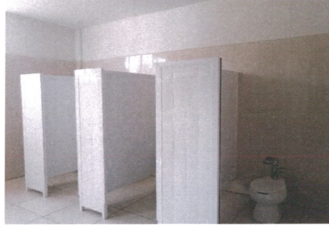
F2- Sanitarios - azulejo, muebles de baño, mamparas
