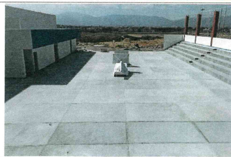
F4- Vista norte - cancha
