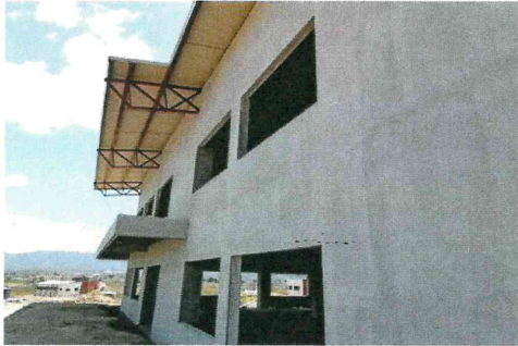
F1- vista de perfil del edificio de Cafetería
