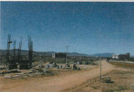
F3- Vista Oeste - Este
