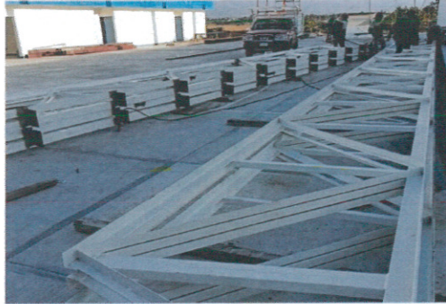
F2- Union de armaduras
