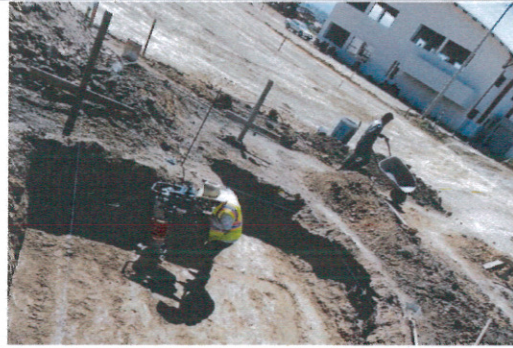
F2- Relleno de cepas con material de banco
