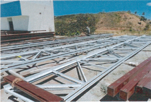
F1- Soldadura y Primer en armaduras
