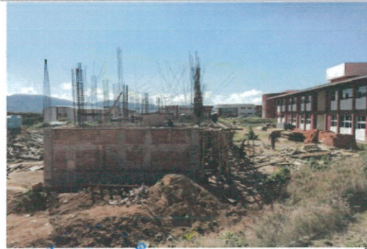
F4- Muros, castillos y cadenas
