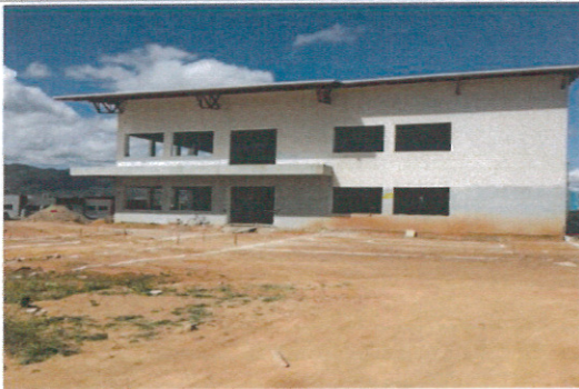
F1- Pintura vinilica en exterior
