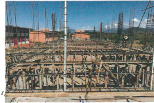
F5- Armado de traveses
