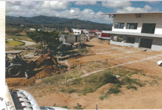
F5- Obra exterior
