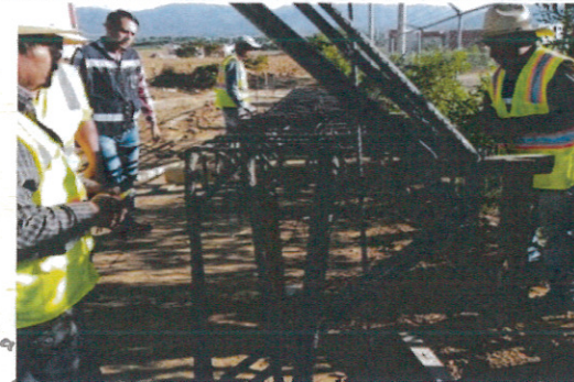
F5: habilitado y armado de acero
