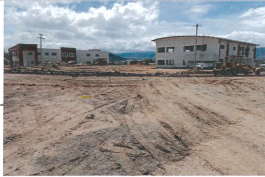
F1- Despalme de area de trabajo
