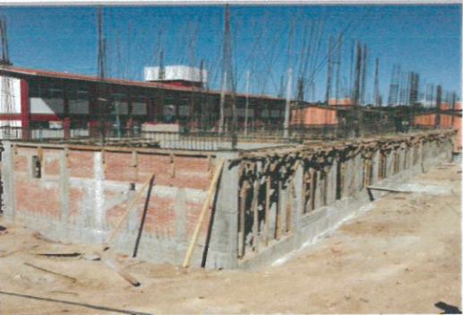
F3- Cimbrado de traveses
