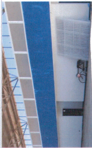
F1- Cubierta de estructura metálica y lamina multipanel
