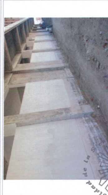
F5- Relleno para banquetas
