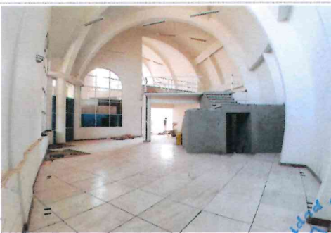
F4- Colocacion de loseta en planta baja
