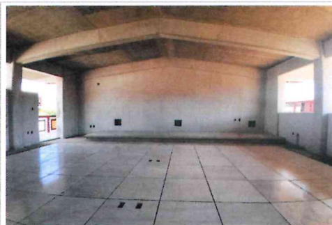
F3- Interior planta Alta, limpieza para aplicar pintura vinilica
