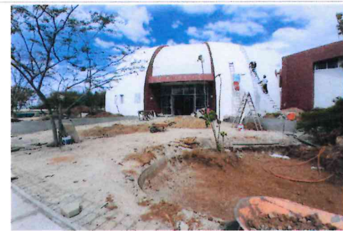
F5- Impermeabilizacion de azoteas
