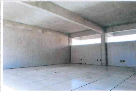
F1- Interior planta baja, limpieza para aplicar pintura vinilica
