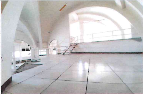
F1- Colocacion de loseta en planta alta
