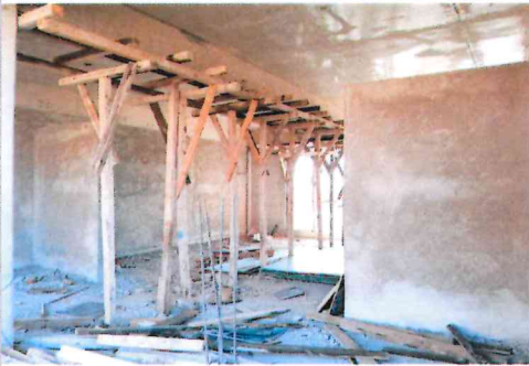
F1- Aplanado rustico en baños
