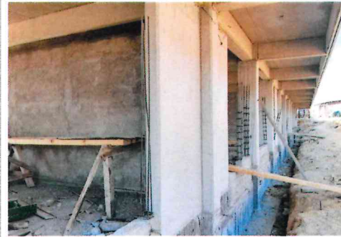
F2- Muros bajos planta baja
