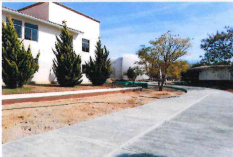
F2- Comunicacion de bibliotecas con andador de concreto
