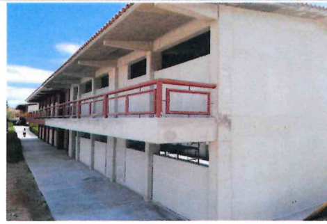
F2- Fachada frontal, limpieza para recibir pintura vinilica
