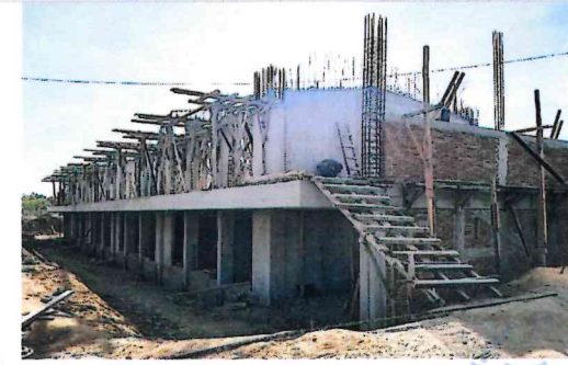
F5- Cimbrado y armado de trabes de azotea
