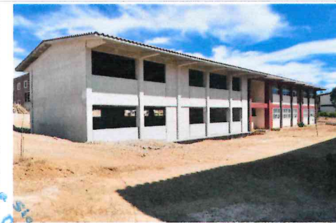
F6- Fachada posterior, limpieza para recibir pintura vinilica
