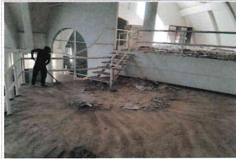
F1- Retiro de loseta fracturada y deteriorada
