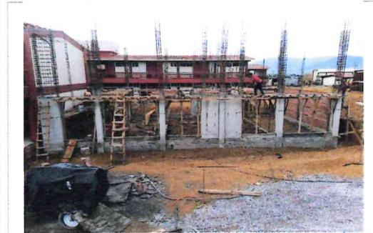
F5- columnas de concreto, muros de ladrillo, y fondeo para recibir acero de trabes
