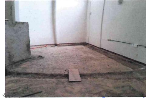
F4- retiro de loseta y excavaciones para renovar ramaleos electricos
