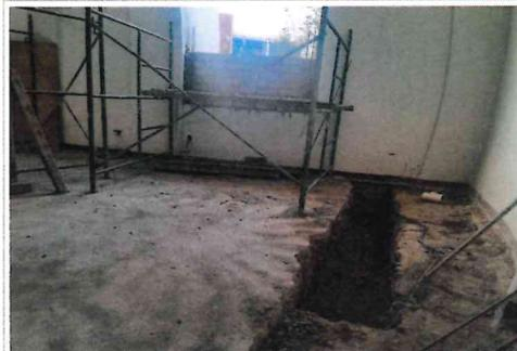
F3- excavación para renovar instalaciones sanitarias
